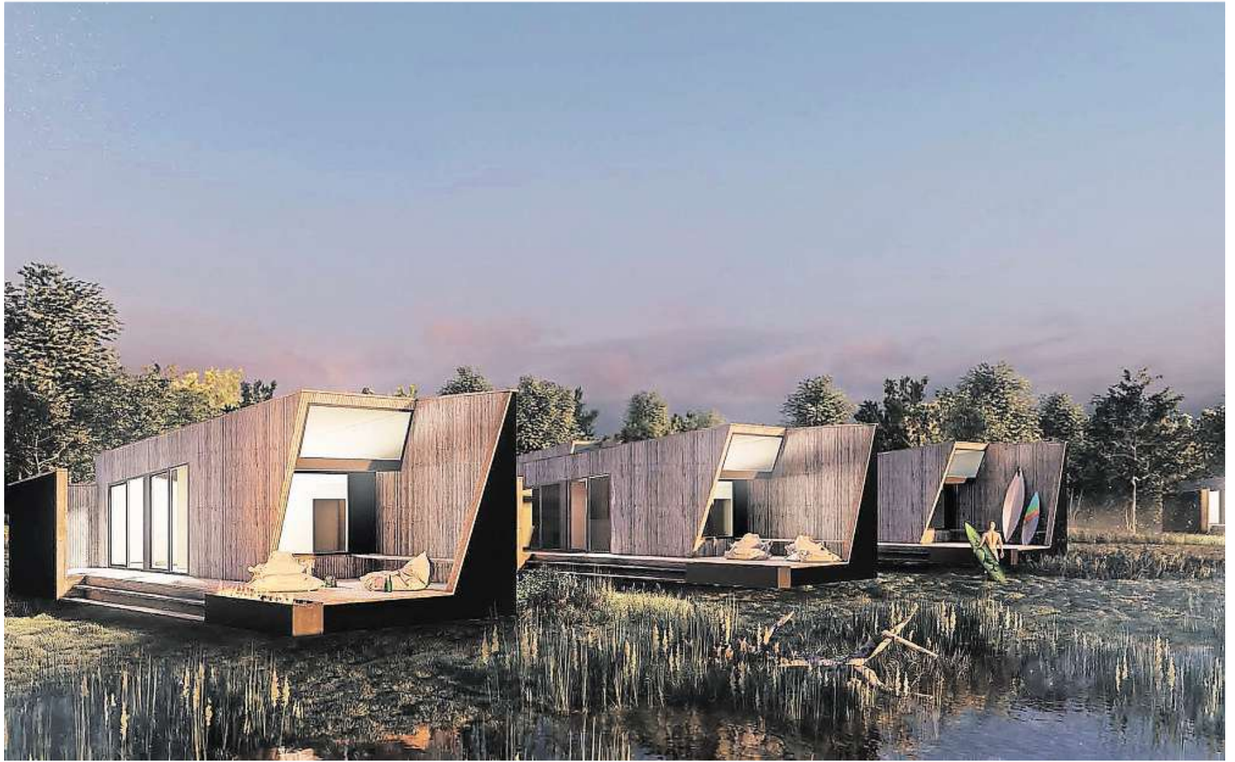
So sehen die Entwürfe für die Tiny Houses am Elfrather See aus.
